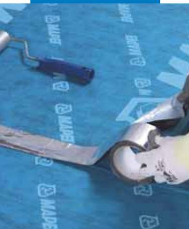
Una volta verificata la perfetta sovrapposizione di Mapesilent Roll, chiudere e sigillare tutte le sovrapposizioni con il nastro argentato Mapesilent Tape
