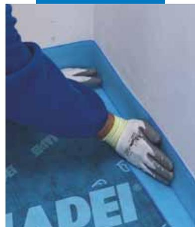
Accostare le varie strisce di Mapesilent Band. Asportare il film di protezione ed incollare per tutto il perimetro della stanza
