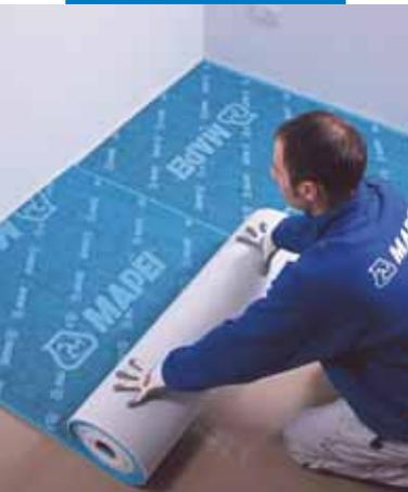
Aprire il rotolo di Mapesilent Roll posizionarlo alla base della parete ed iniziare a distenderlo con lo strato fibroso (parte chiara) rivolto verso il basso, seguendo il lato più lungo della stanza. Stendere il secondo telo, posizionandolo alla base della parete avendo cura di sovrapporlo al primo di almeno 5 cm
