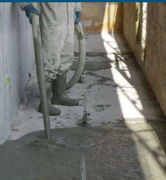
I Sottofondi alleggeriti sono utilizzati per la creazione del primo strato isolante di copertura degli impianti.
